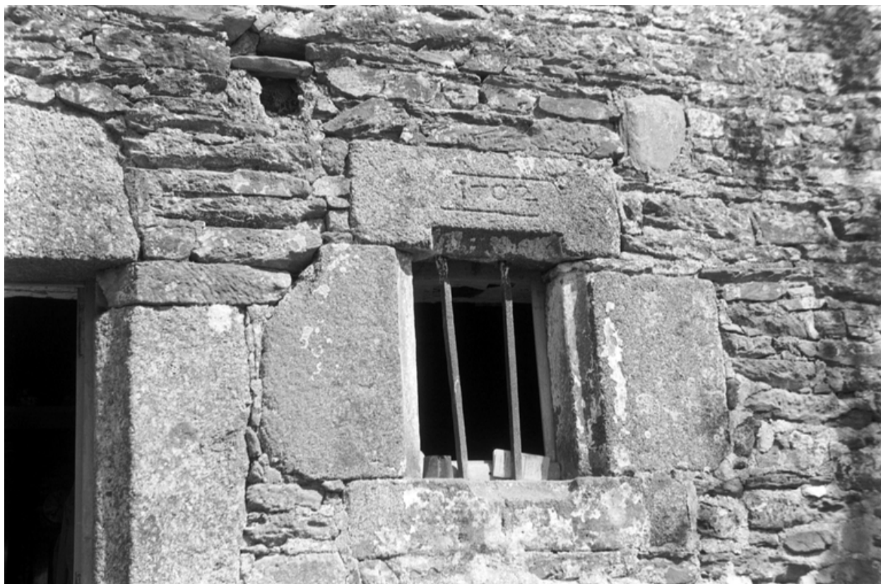
Détail de la fenêtre, 1er niveau
