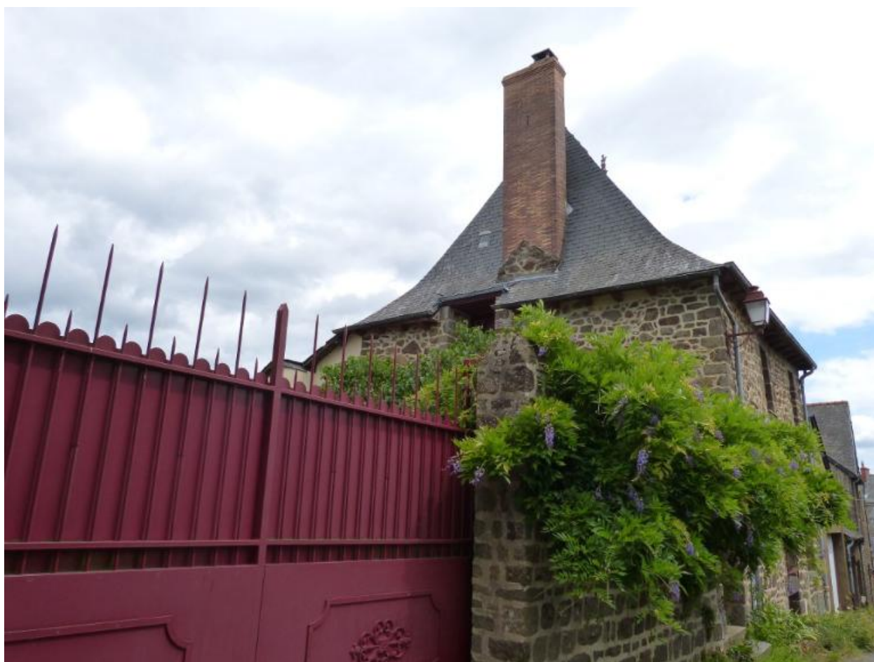
Vue sud ouest
