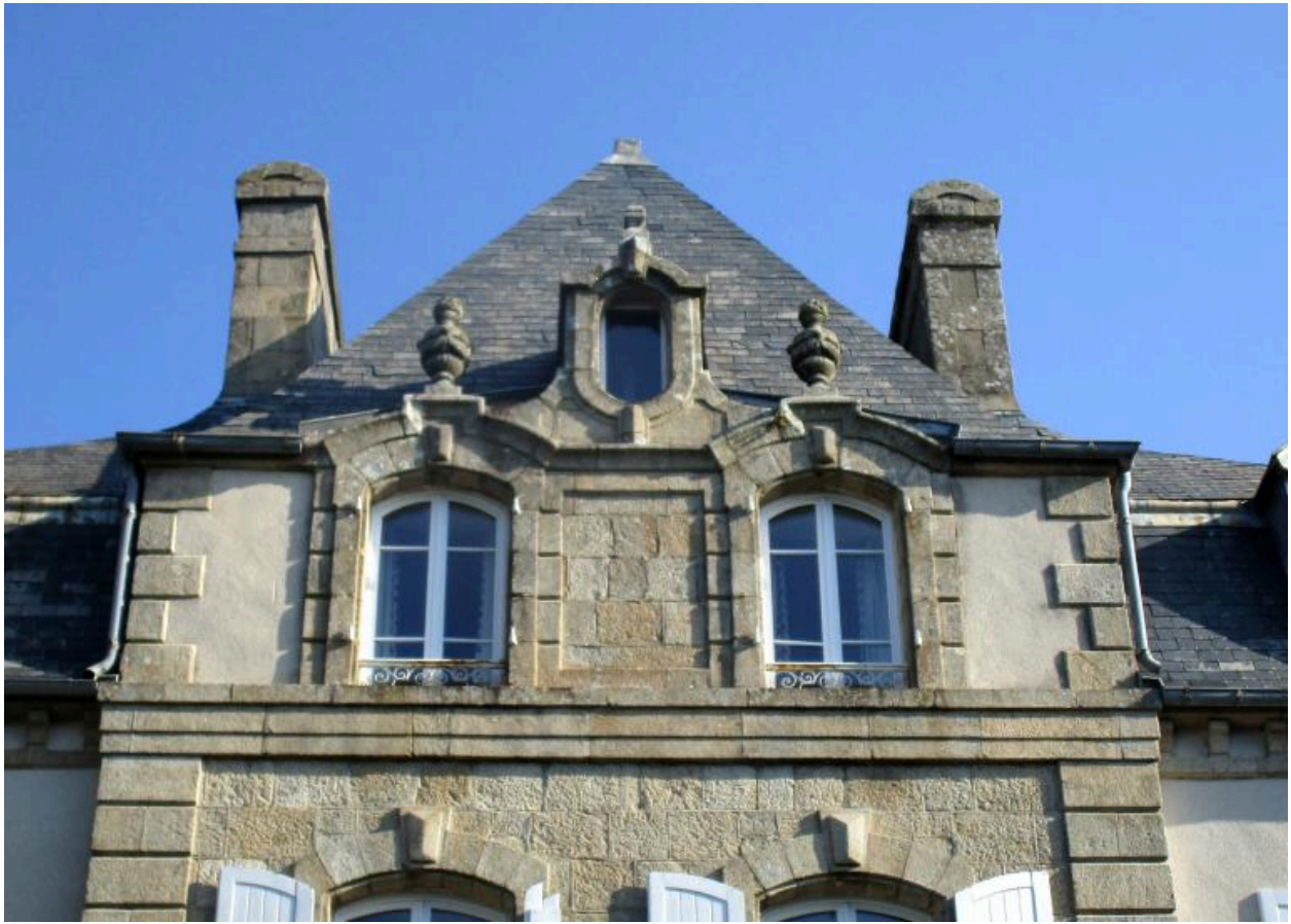
Elévation sud, corps central, détail des lucarnes. (2023)
