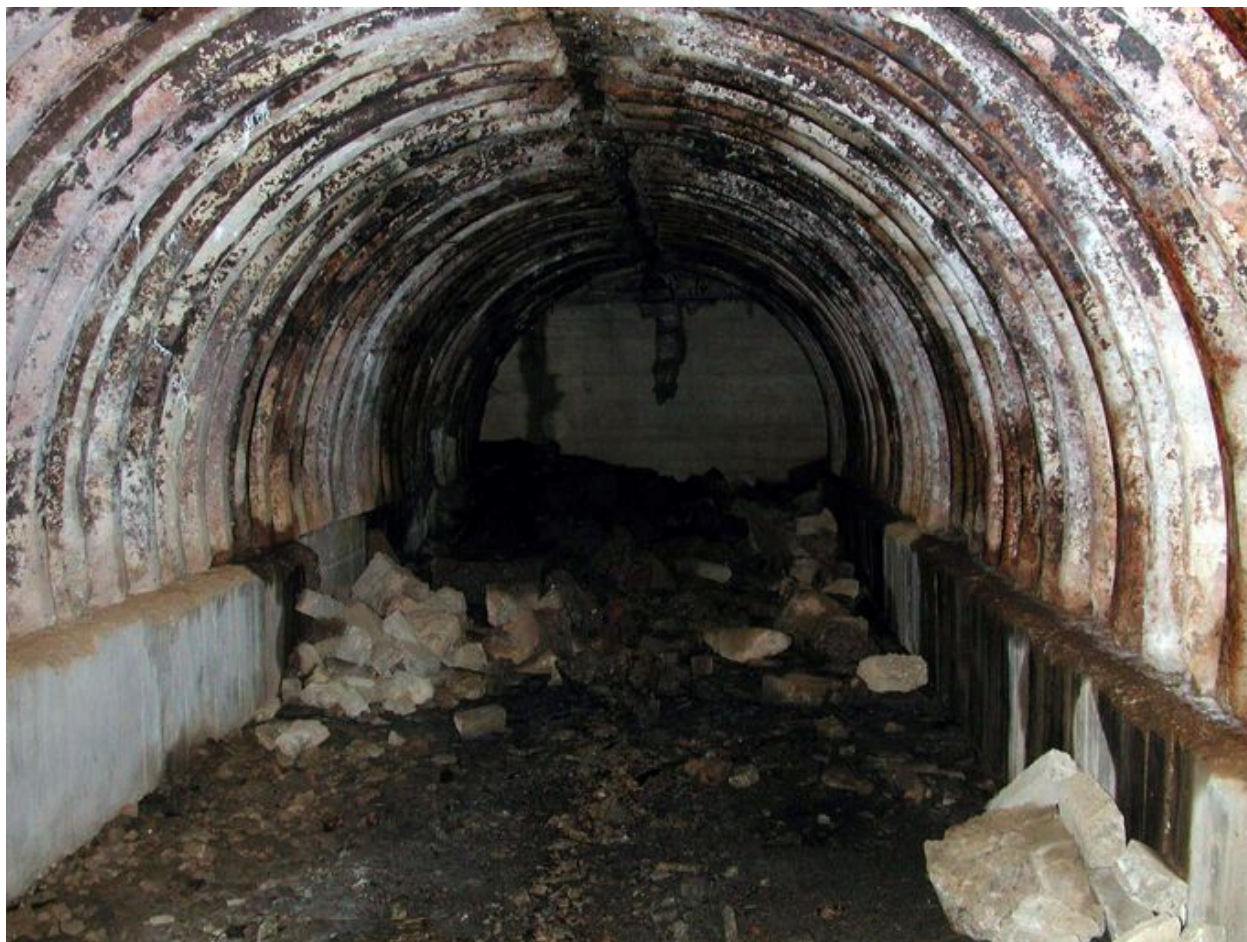
Vue de la batterie antiaérienne de Keroual : abri souterrain type tôle métro (situé au sud de l'ensemble fortifié)
