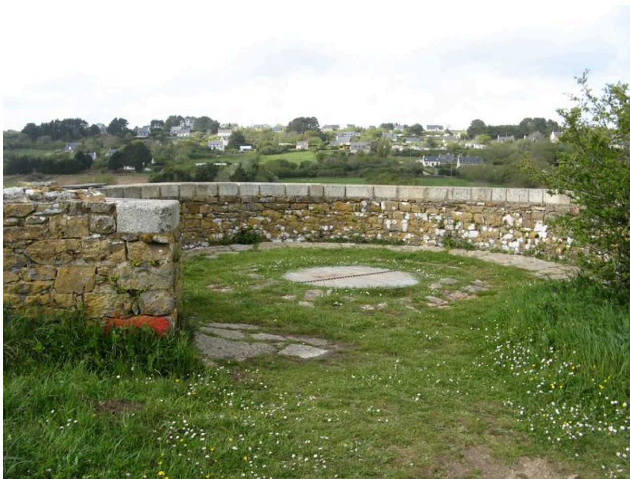
Gueulard du four à chaux de Rozan
