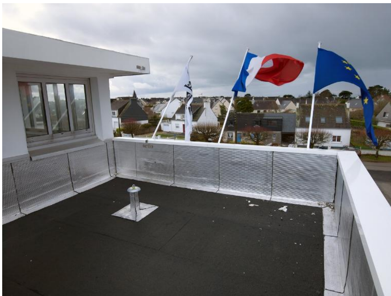
Toit terrasse de la tourelle de l'externat, pris du nord vers le sud.
