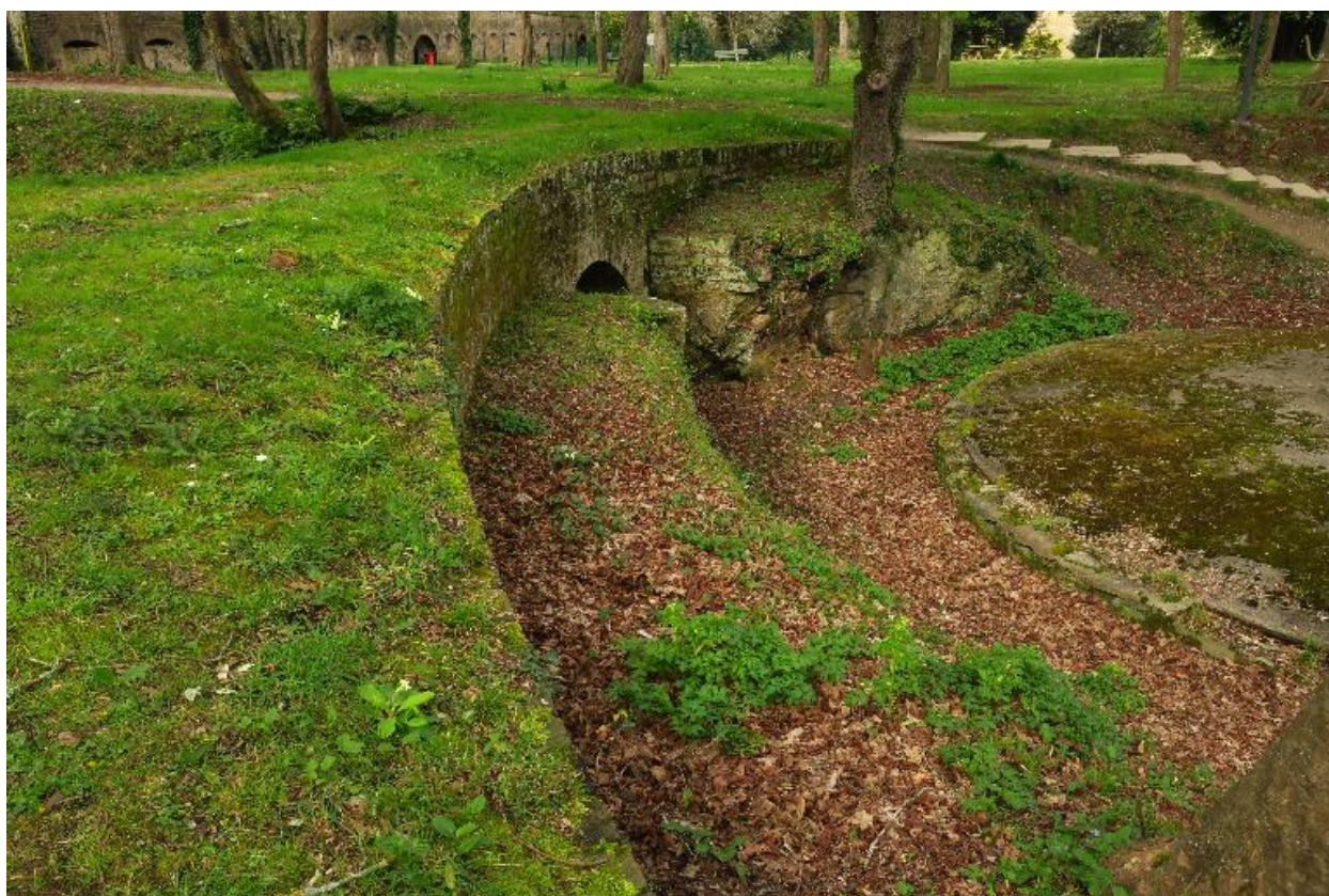
Le Palais, enceinte urbaine, courtine 20-21, place d'armes et citerne.
