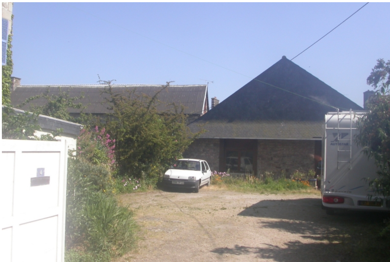
Vue générale du bâtiment ouest.
