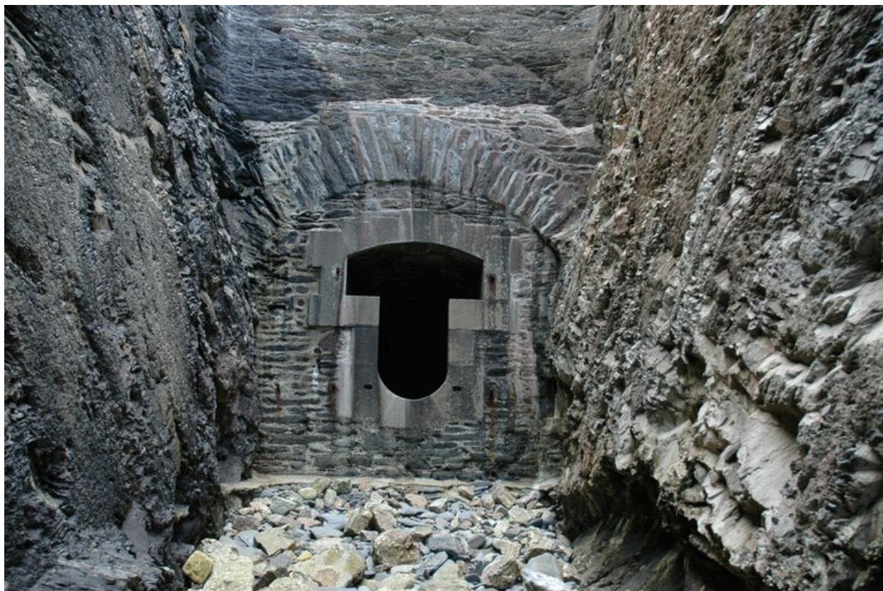
Vue de l'une des deux embrasures : couloir aménagé dans le terre-plein / falaise de la batterie de Vauban pour permettre le passage des obus (état en 2005)
