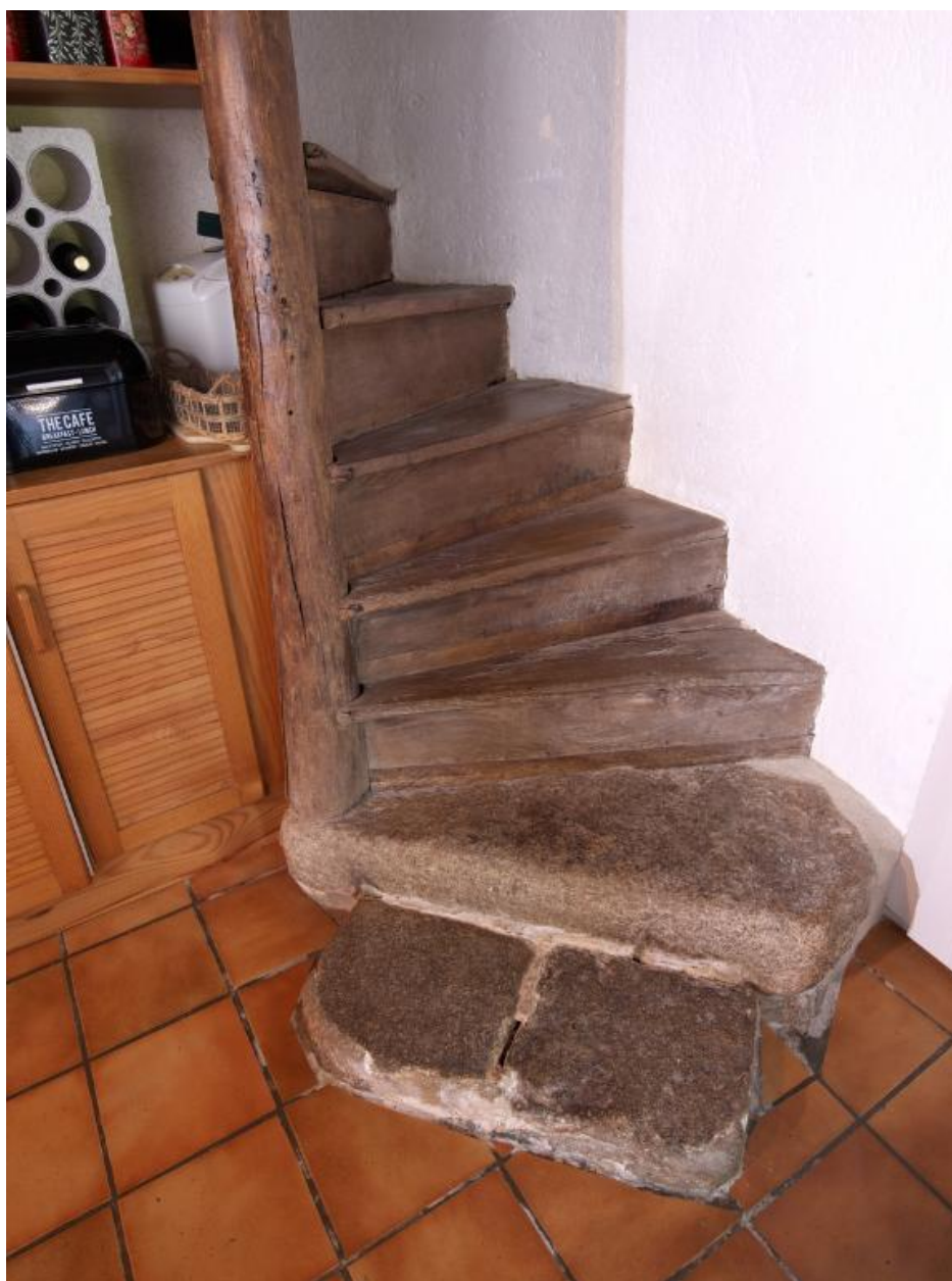
Vue rapprochée de l'escalier à vis.
