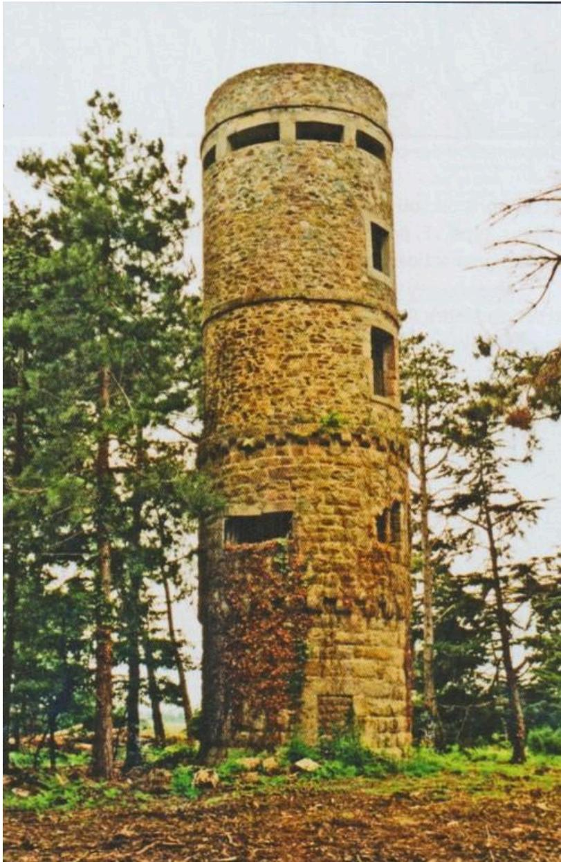
Vue du moulin à vent transformé en poste d'observation d'artillerie durant la Seconde Guerre mondiale (état dans les années 1990). Trois phases de construction sont visibles dans la maçonnerie
