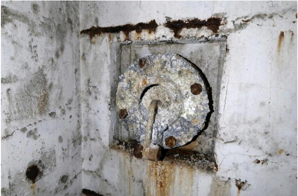
Vue du sas : mur est avec bouche de surpression à clapet à contrepoids en aluminium
