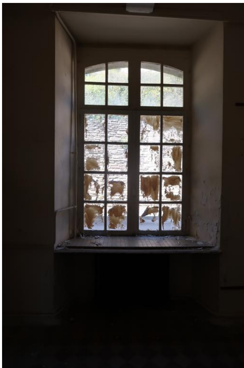
Vue intérieure : rez-de-chaussée, fenêtre à petits bois donnant vers le nord (état en 2022)
