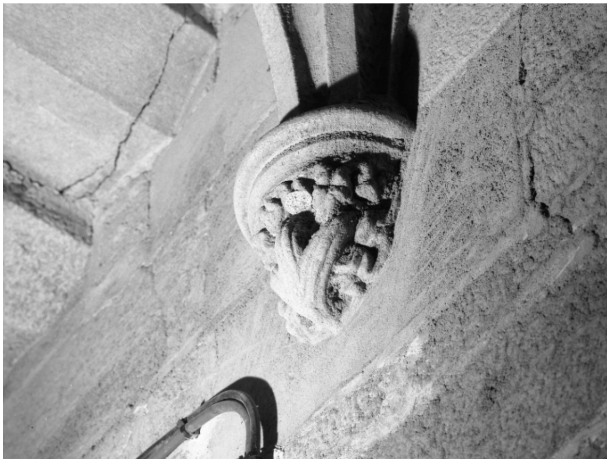
Rez-de-chaussée, couloir : détail du cul-de-lampe nord est
