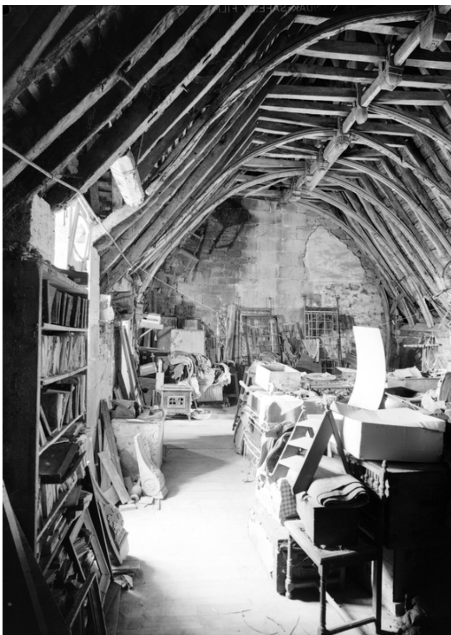
Combles nord du corps central : charpente et mur ouest
