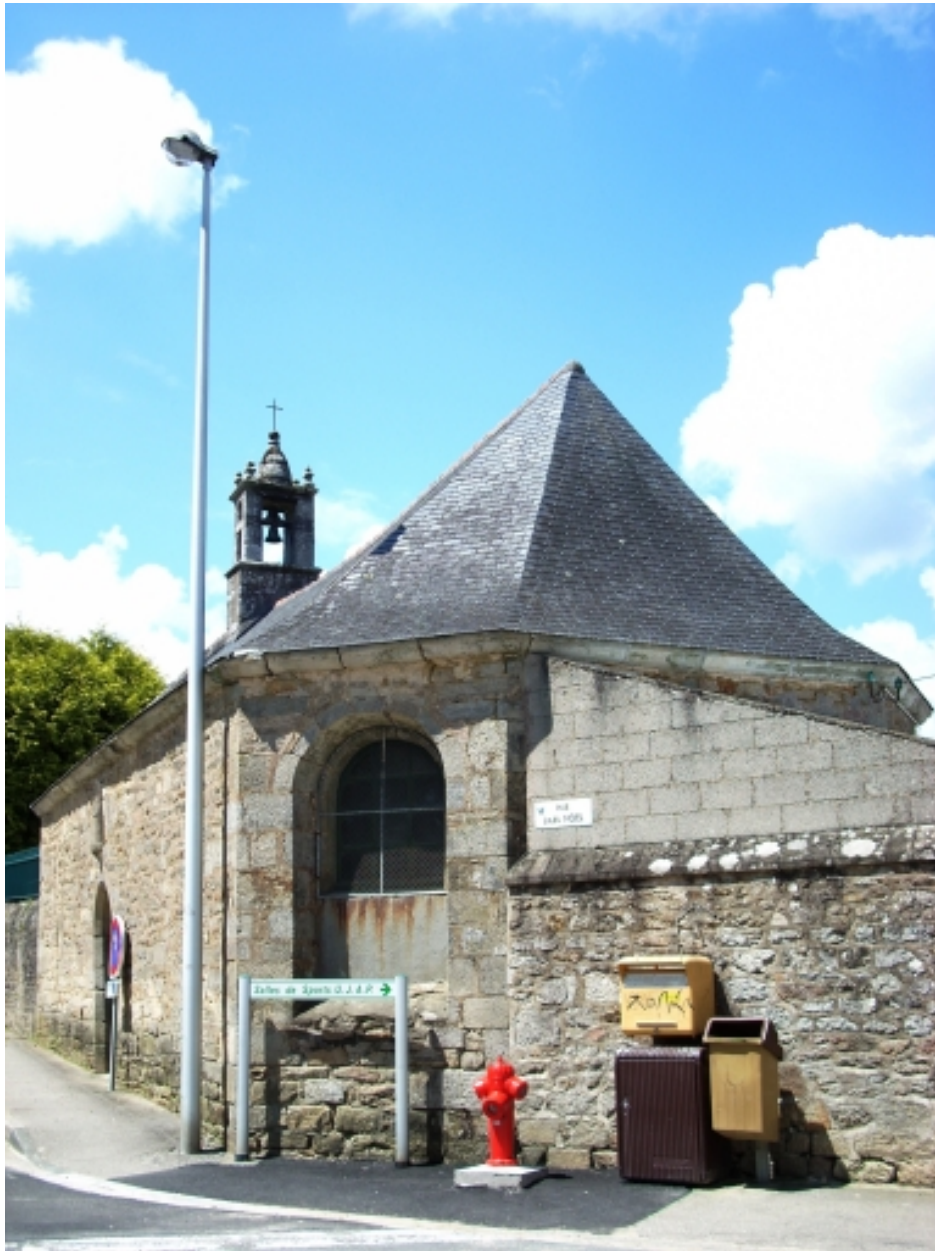
Quimper, chapelle Saint-Marc : vue générale sud-est
