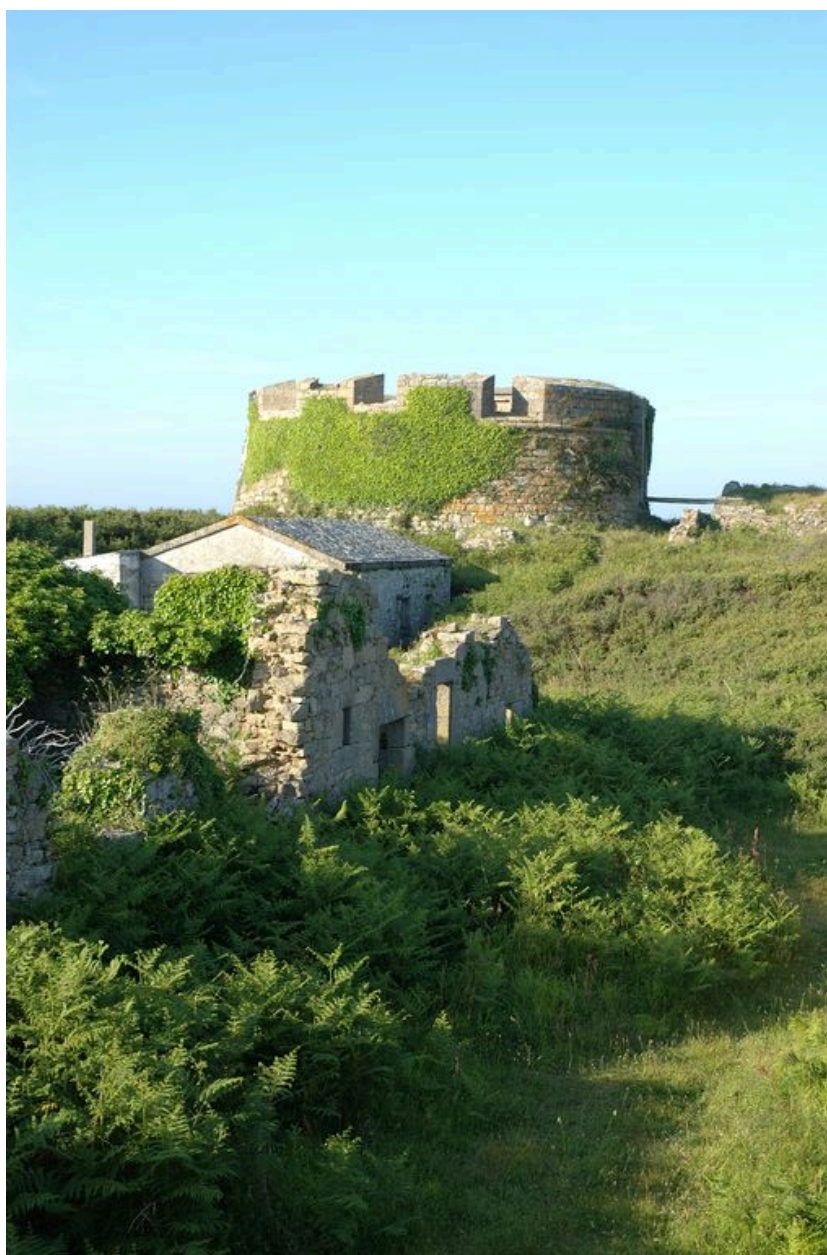
Vue générale du fort Cézon : casernes, magasin à poudre et tour d'artillerie
