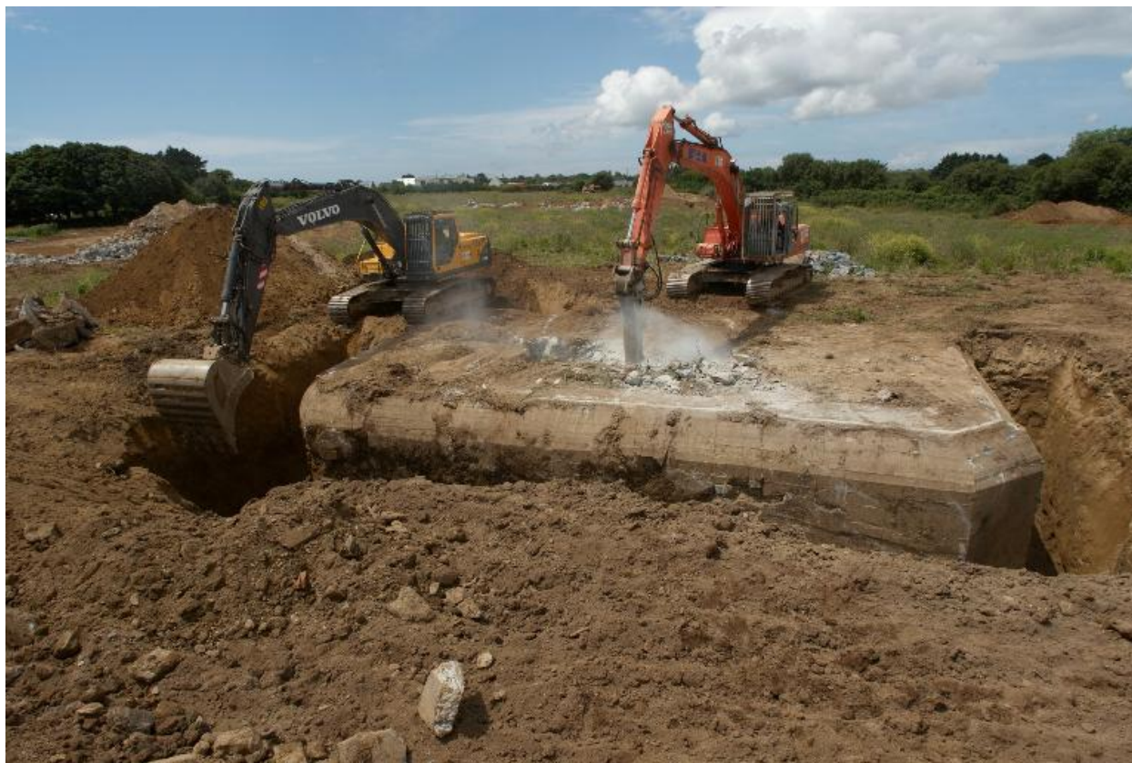
Déconstruction d'un bunker de type 502
