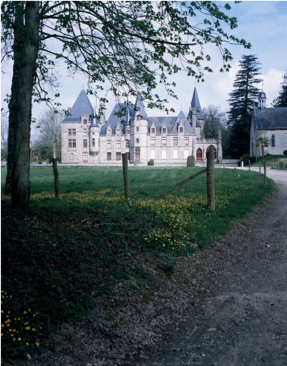
Vue générale du château.
