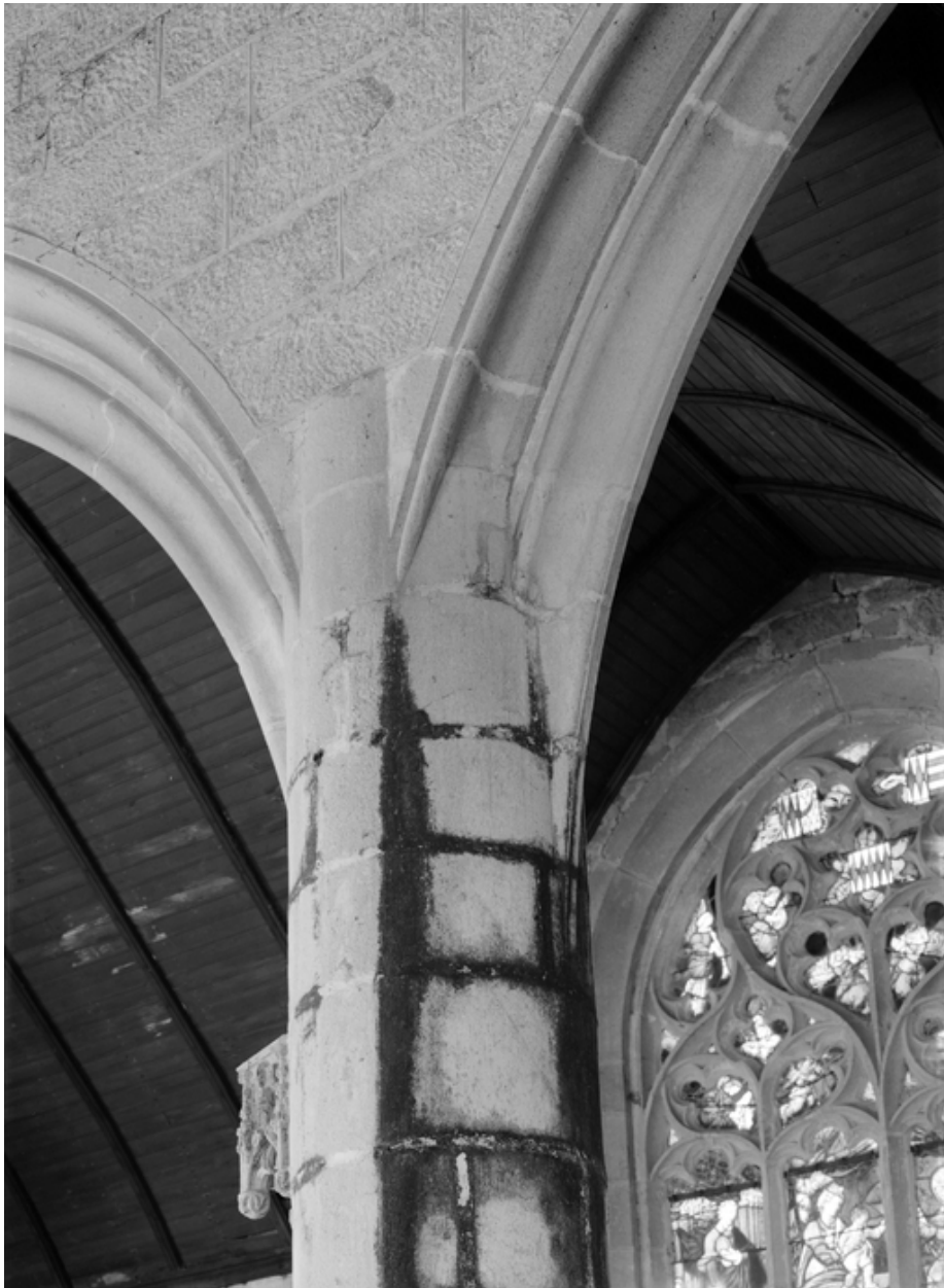
Retombée des arcades sur la pile de la nef.
