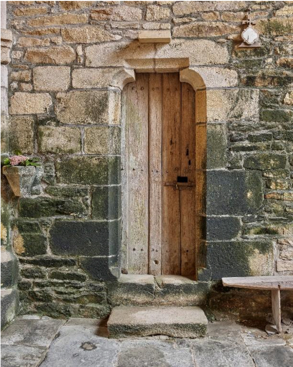
Porte d'accès au clocher située dans le transept nord
