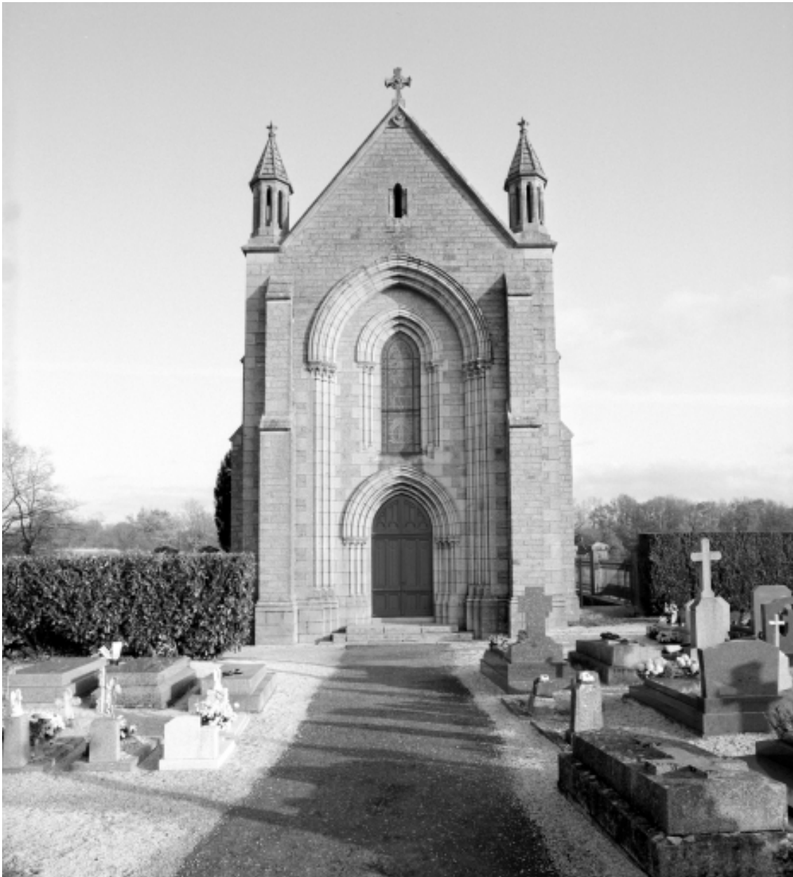
Elévation Ouest : vue générale
