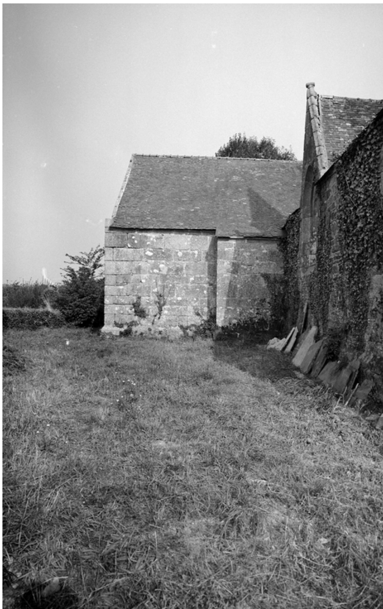
Façade nord, mur ouest du croisillon nord et mur nord de la nef
