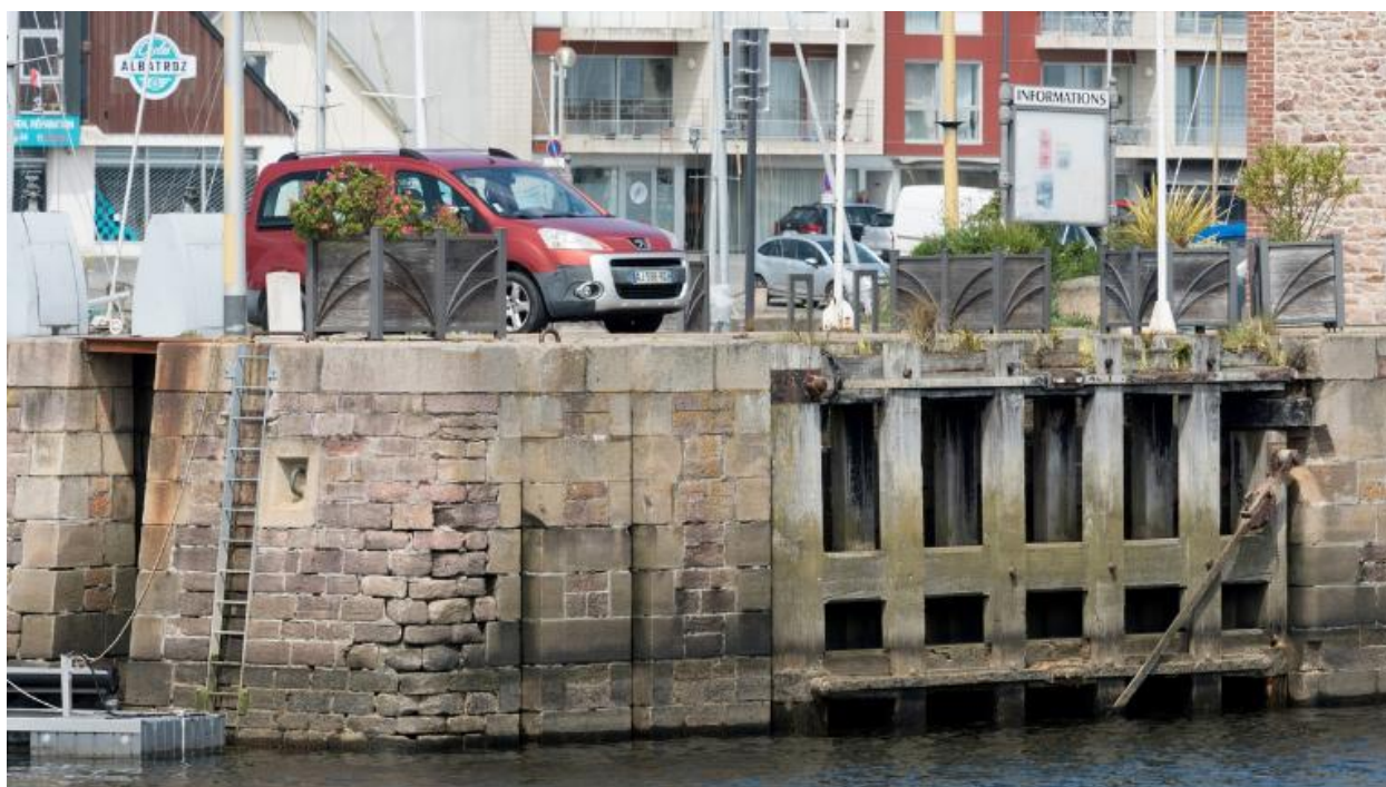
Porte d'écluse du bassin
