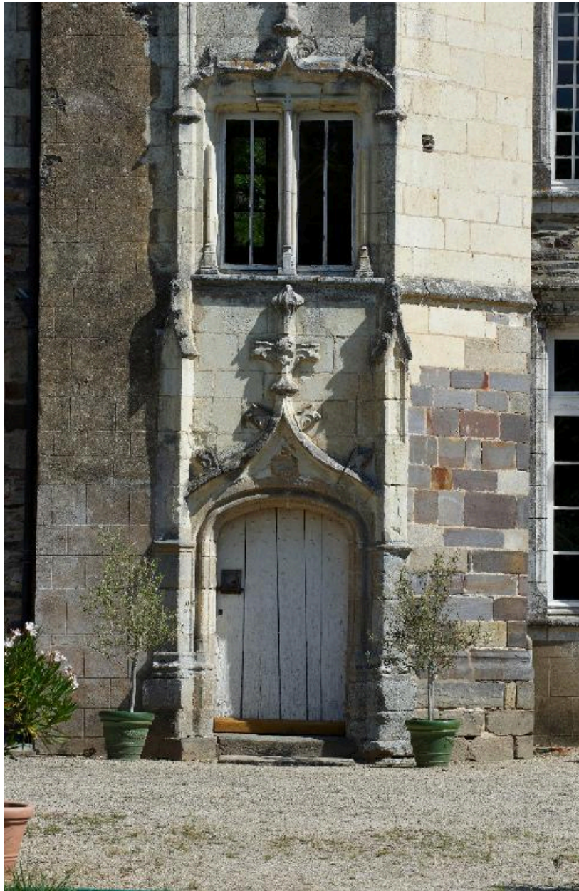
Partie inférieure de la tour d'escalier
