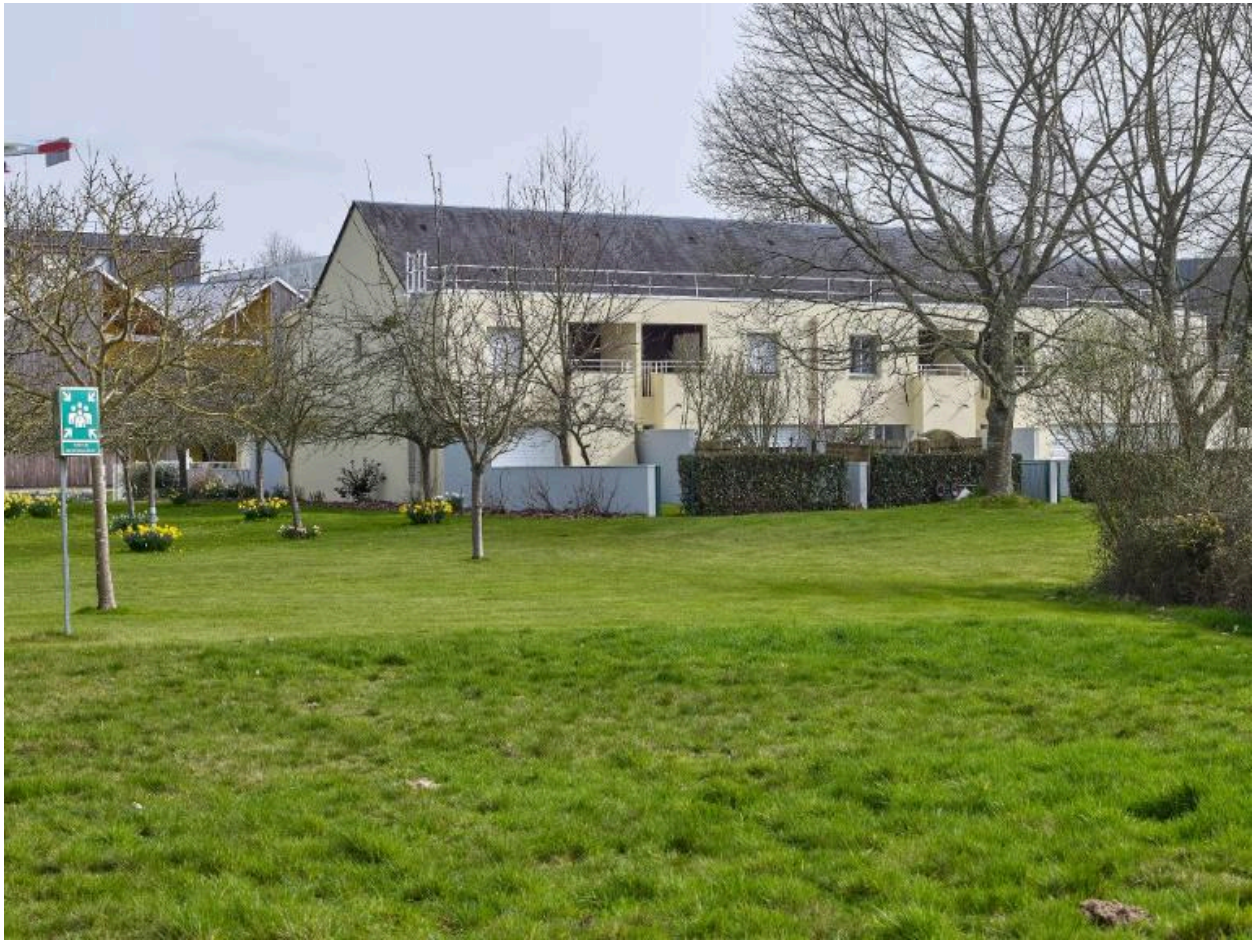
Logements de fonction, façades ouest. Joël Y. Gautier, architecte, 1992.
