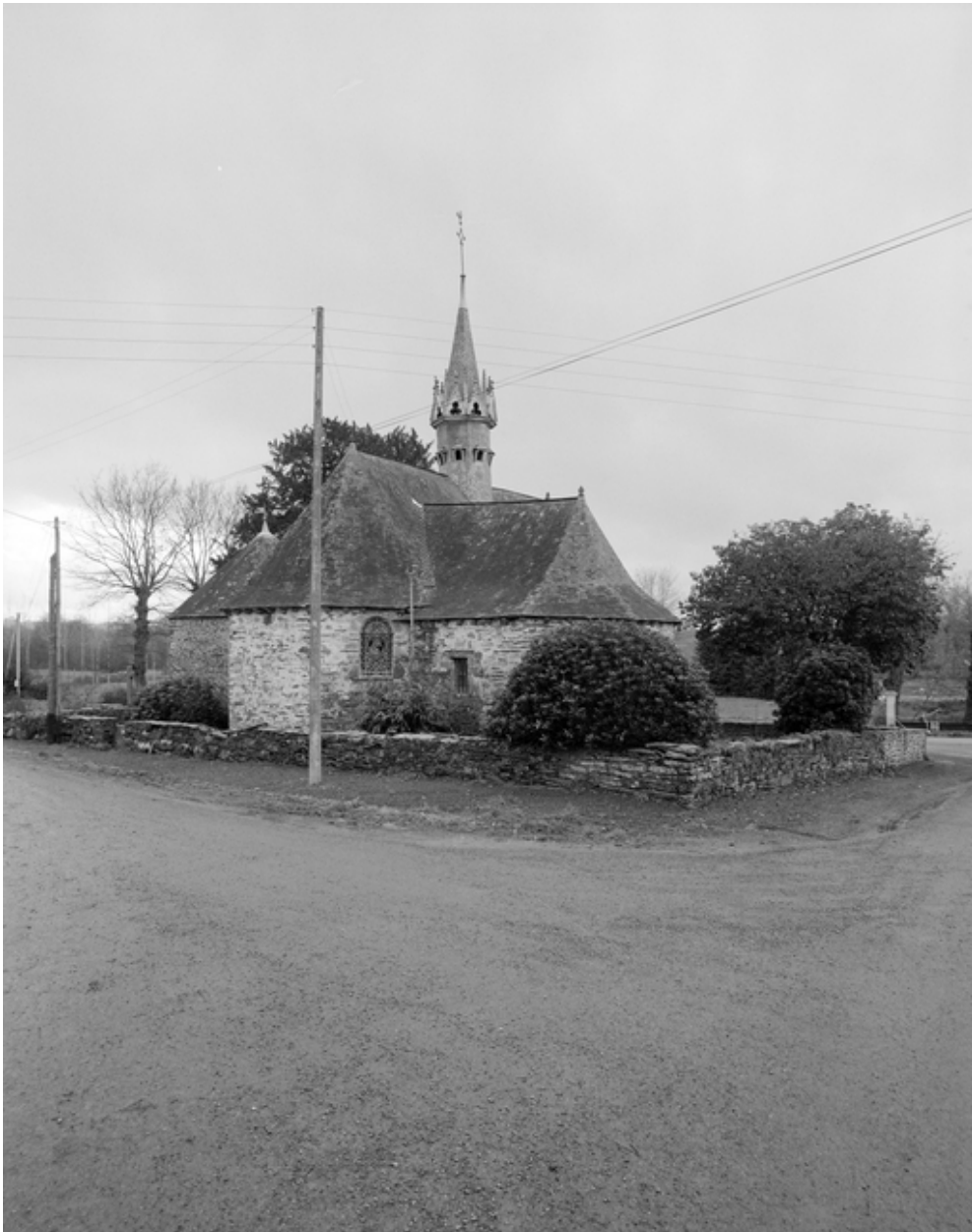
Vue de situation nord-est
