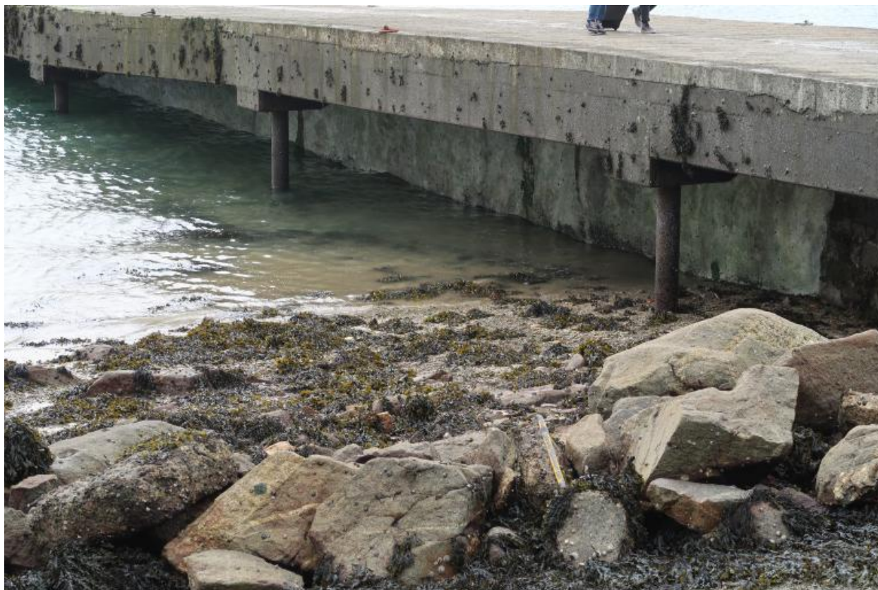
Cale et débarcadère : structure sur pieux (1989)
