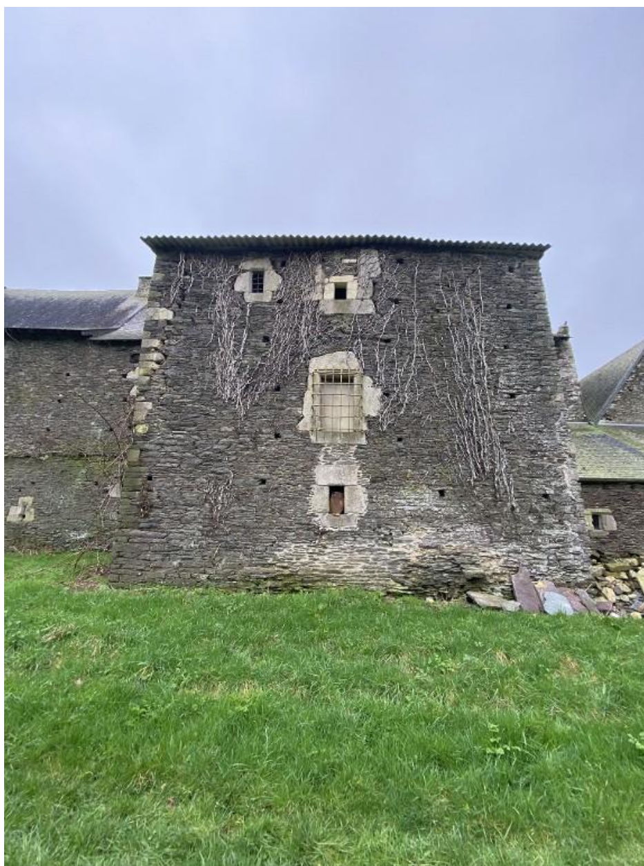
Élévation est, tour
