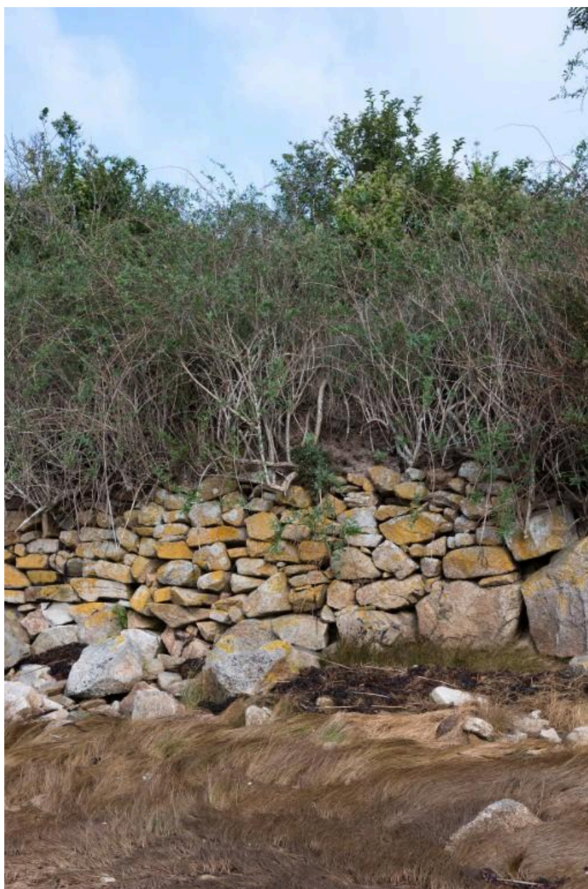
Mur de soutènement aux moellons à l'empilement décalé, au niveau de l'anse de Pelinec
