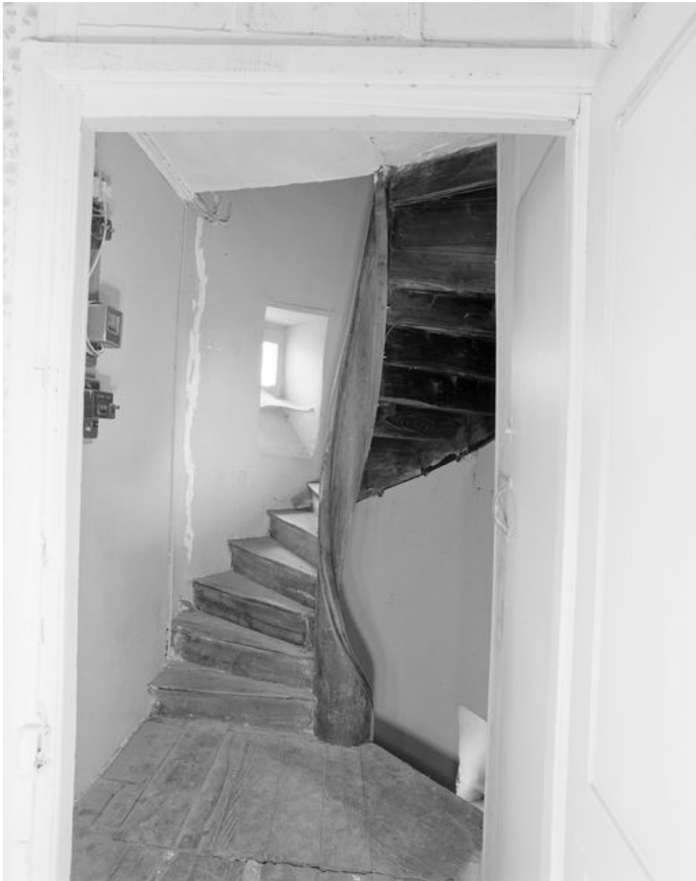
Maison : escalier en vis en bois (état en 1994)
