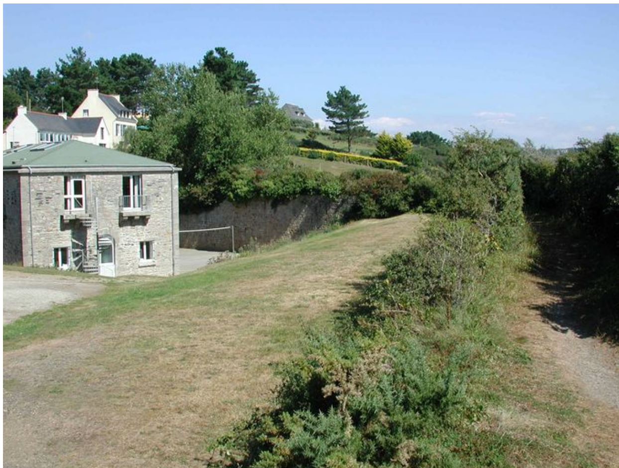
Vue du réduit de batterie de côte de Postolonnec aujourd'hui transformé en centre de colonies de vacances : batterie extérieure
