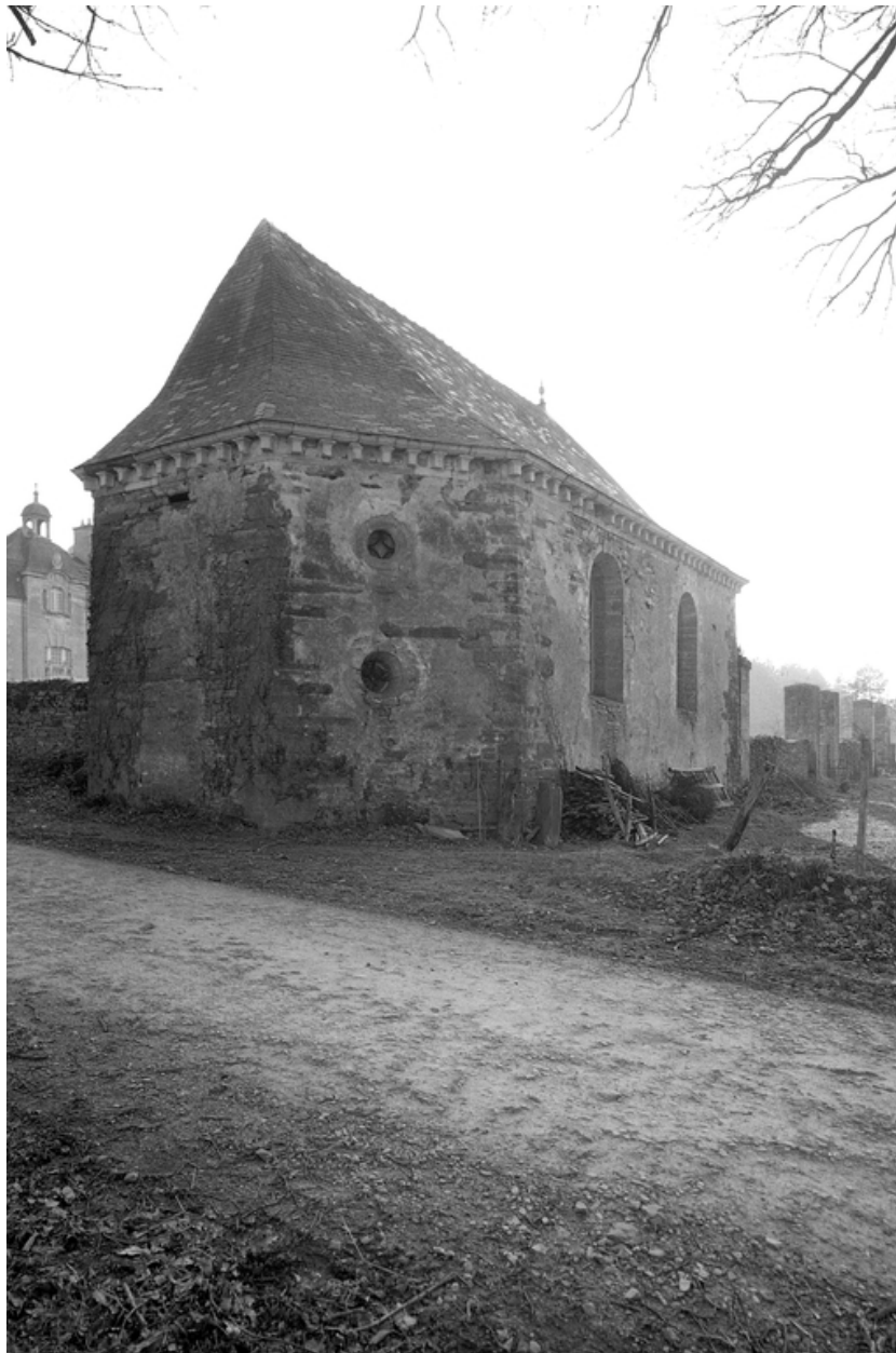
Chapelle, vue nord-est, vue générale.
