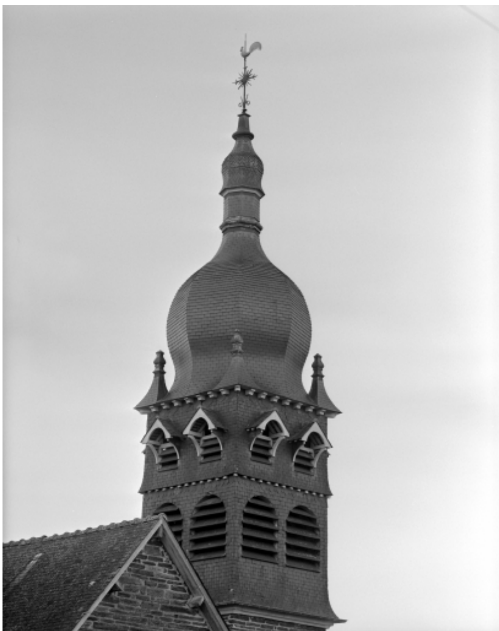
Elévation Nord-Est, Clocher : vue générale
