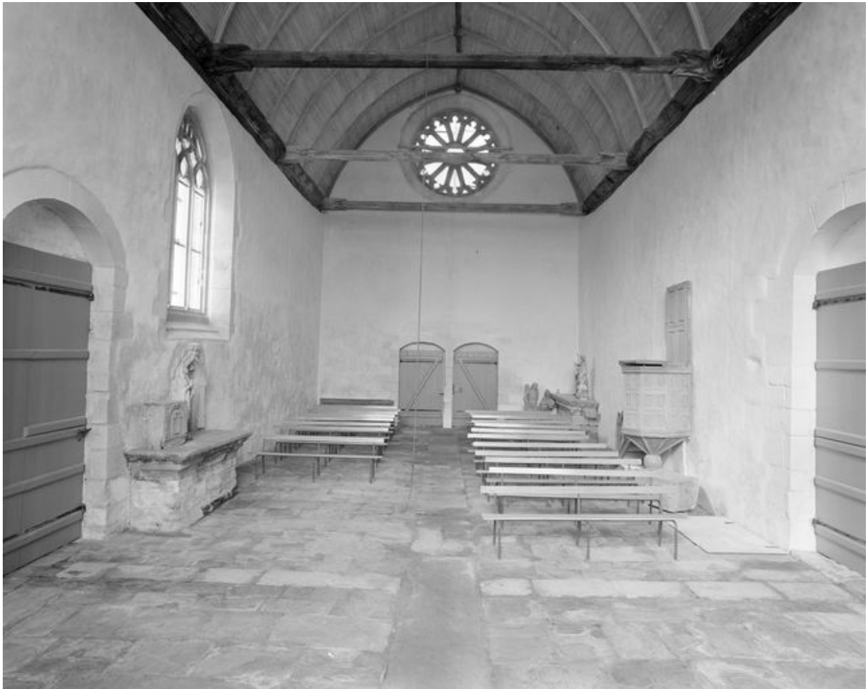
Vue générale vers la nef
