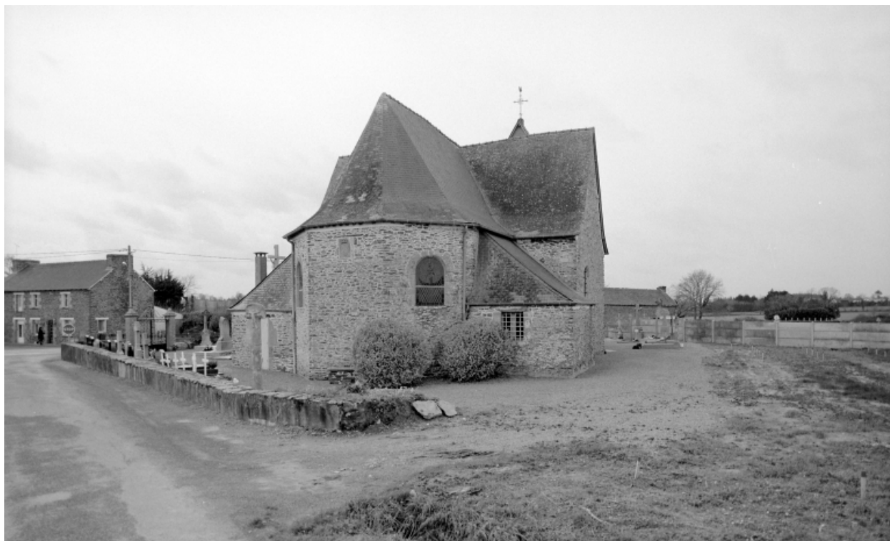
Elévation Est : vue générale
