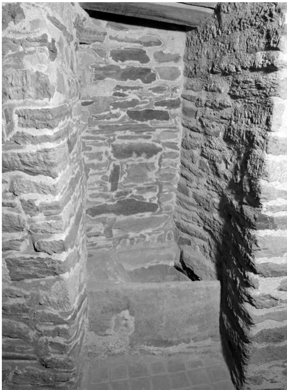
Chemin de ronde, latrines.
