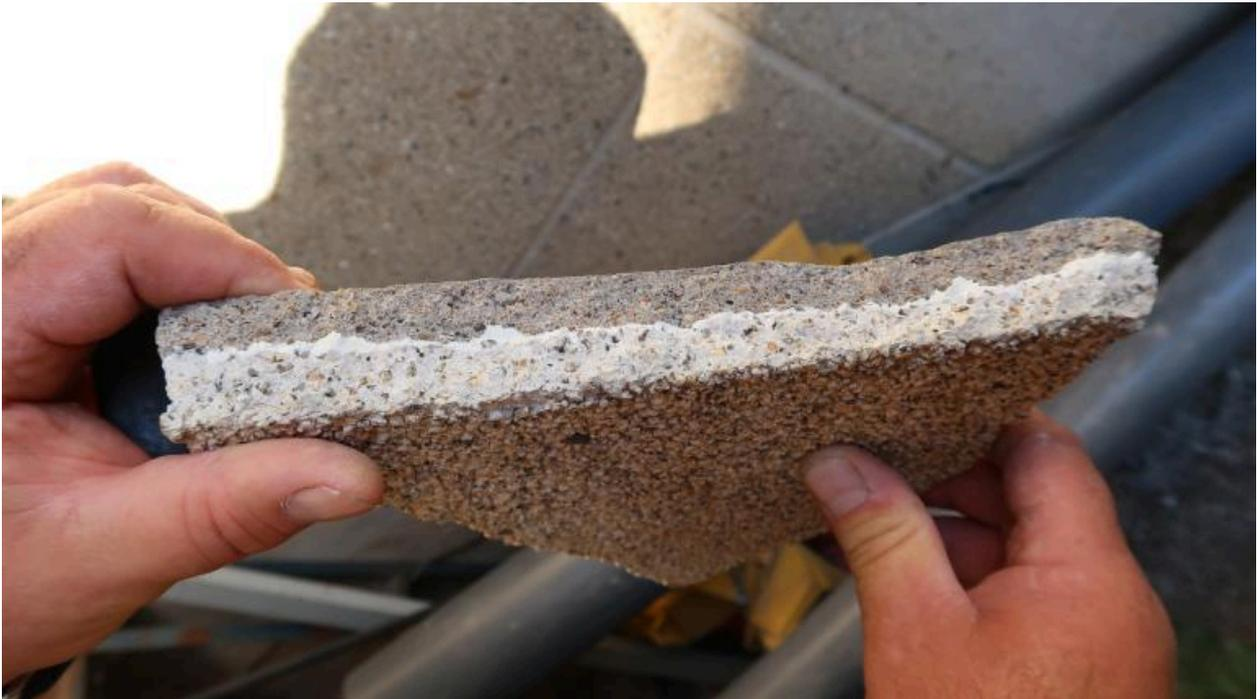
Morceau du revêtement de façade : enduit lavé en gravillon de granite : "portant en valeur la teinte et l'aspect du granulat si caractéristique de la construction bretonne"
