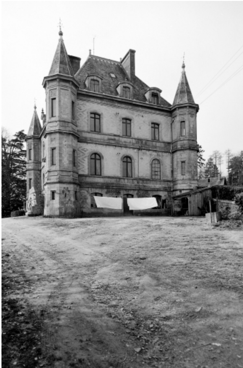
Façade est, vue générale.
