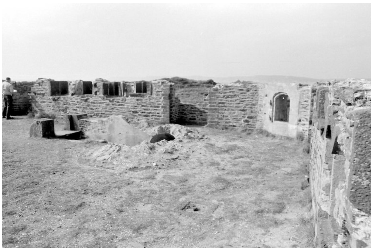
Vue du corps de garde crénelé de l'île de l'Aber en 1972 : terrasse
