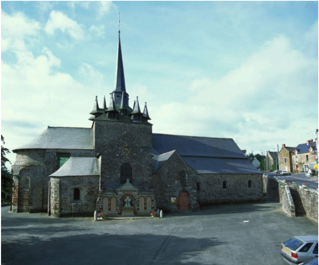
Vue générale nord
