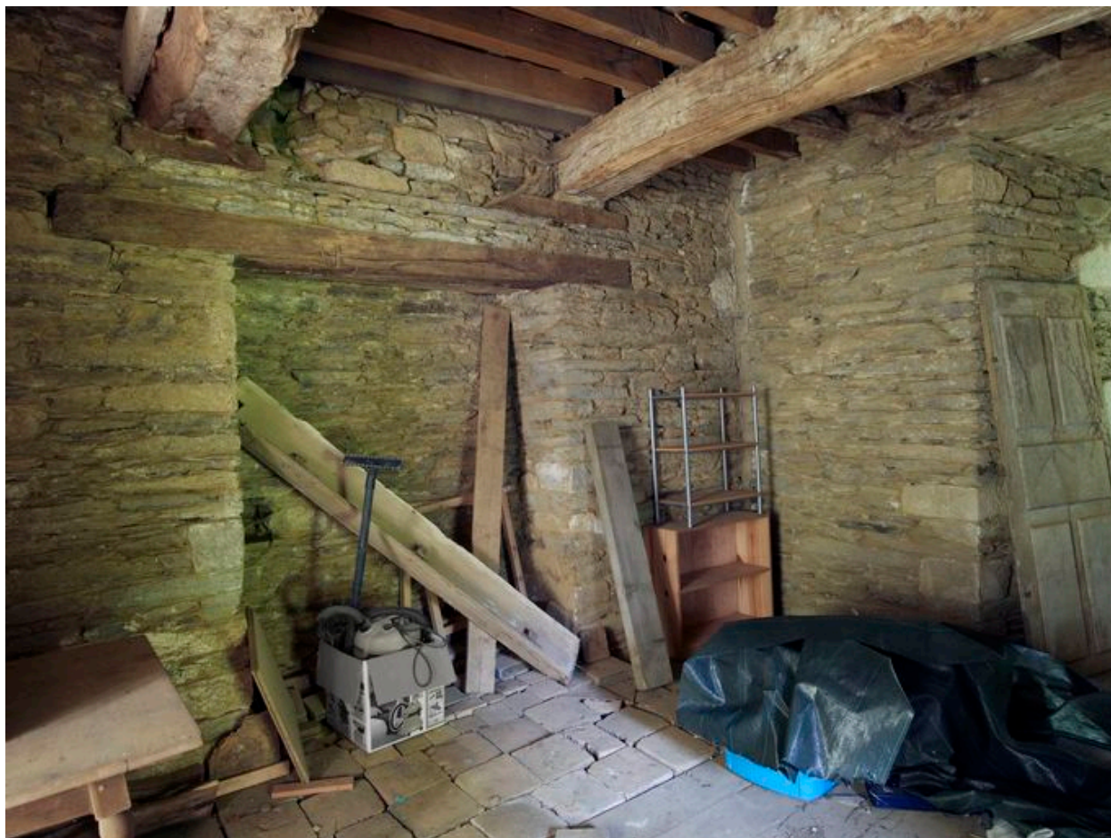
Château, tour isolée nord-ouest : le rez-de-chaussée (état en 2010)
