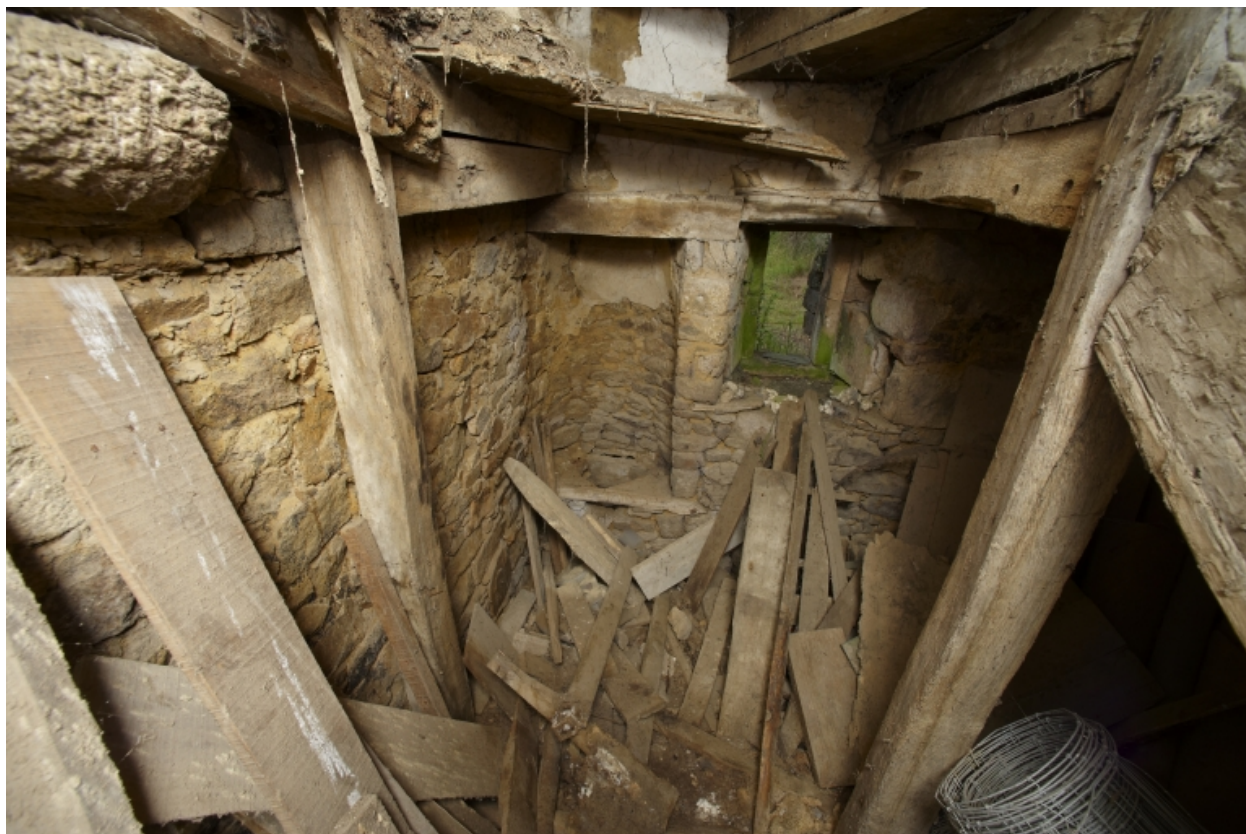
Latrines, rez-de-chaussée du pavillon
