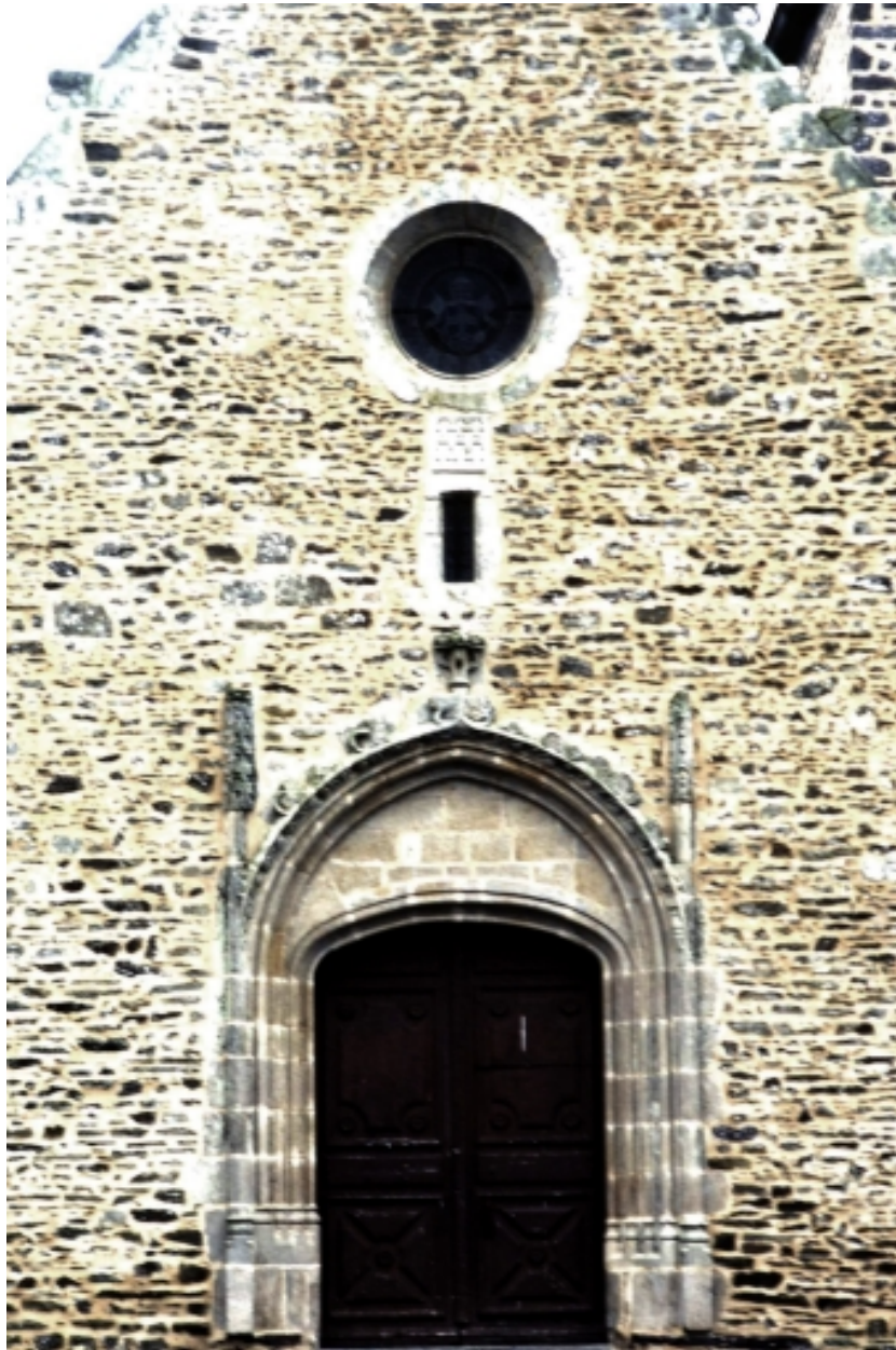
Elévation ouest : vue rapprochée, état en 1994
