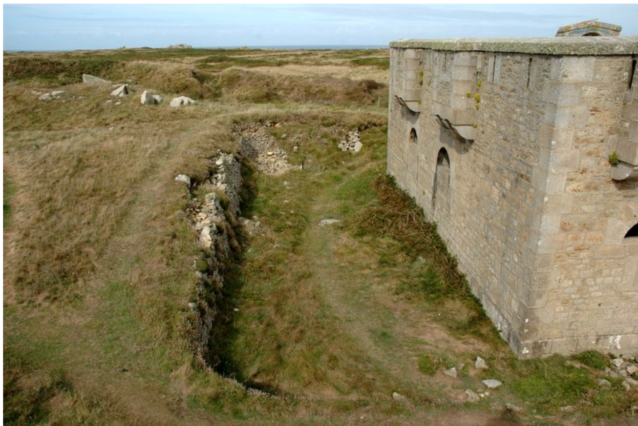
Vue du fossé sec du réduit de batterie de côte de Loqueltas, façade occidentale
