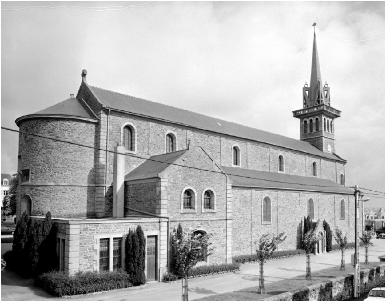
Elévation Sud-Ouest : vue générale.
