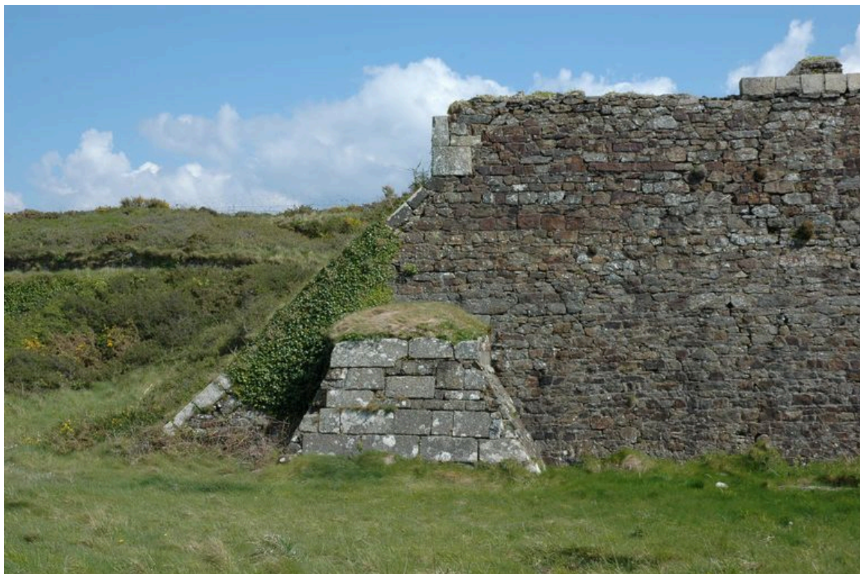
Vue des lignes de Quéléren : entrée des casernements de la batterie de côte ouest (remaniée durant la Seconde Guerre Mondiale)
