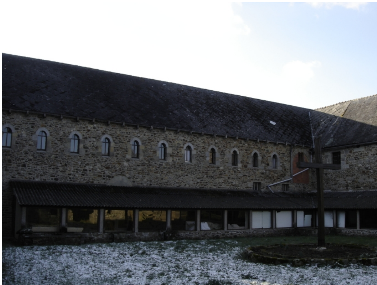
Bâtiment conventuel occidental, vue de l'ancien cloître (2006)
