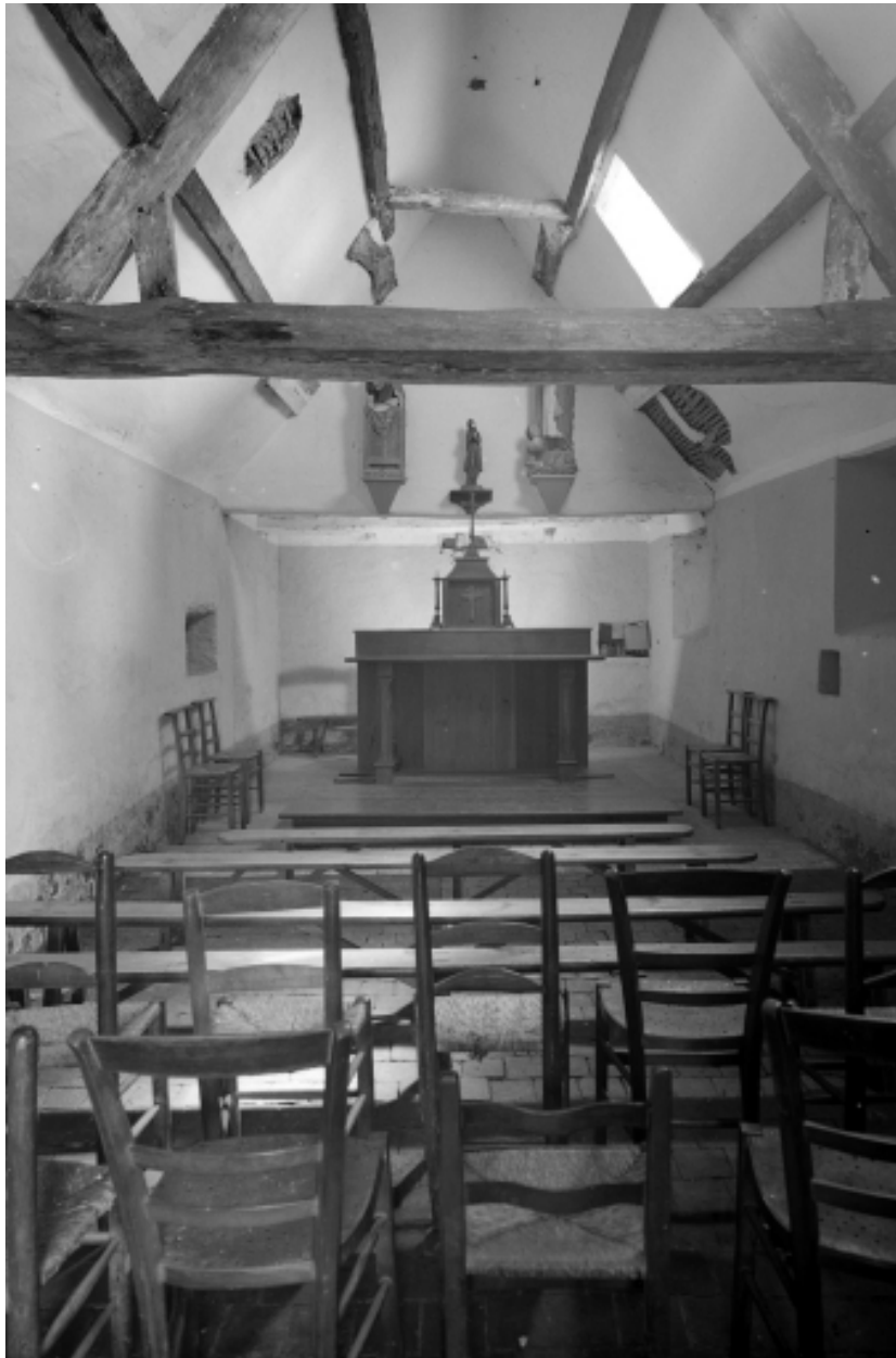
Intérieur : vue générale vers le chœur.
