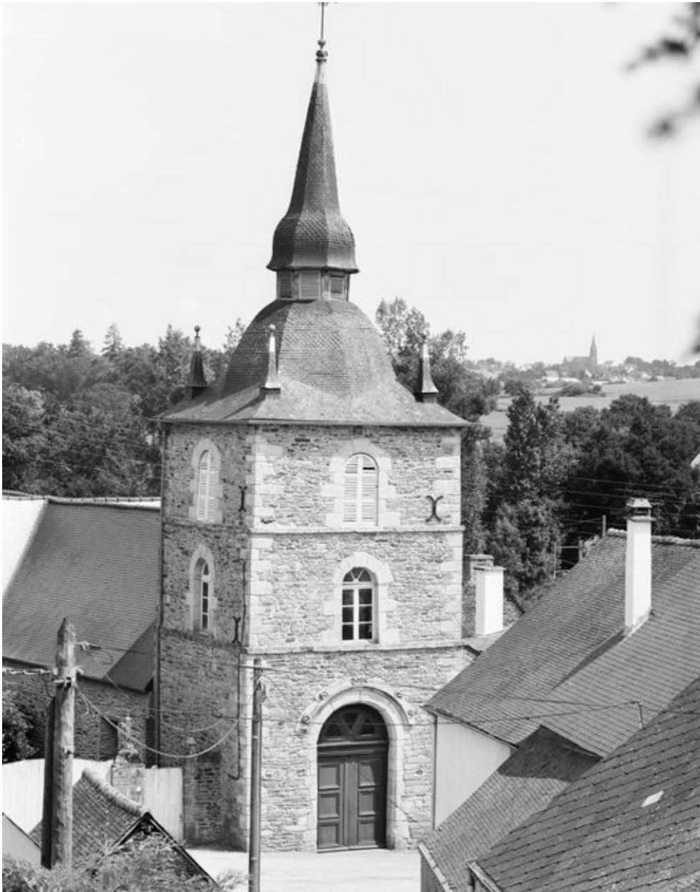
Église Saint-Samson : vue générale du clocher prise de l'ouest
